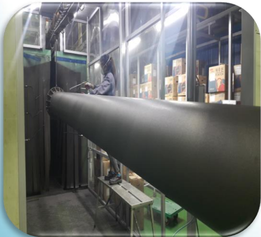
<< 자동 쇼트 후 에어 작업 >>
